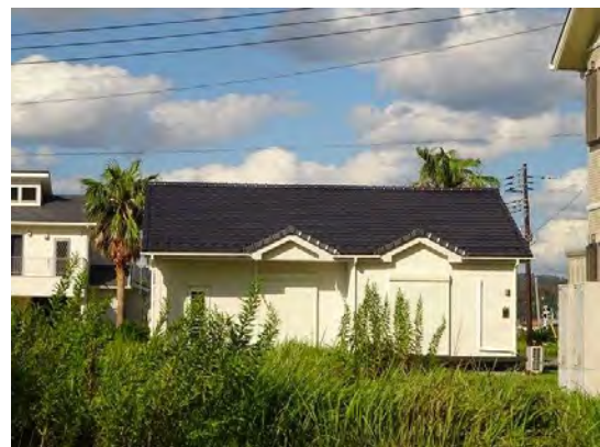
写真 58. 瓦屋根（F形瓦・防災タイプ）被害なし。
