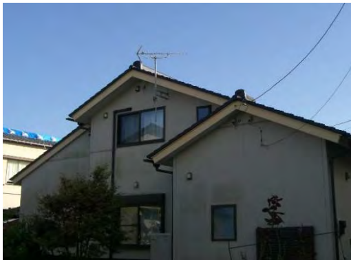
写真 10. 瓦屋根 (J形瓦・防災タイプ) の被害なし (ガイドライン準拠)
