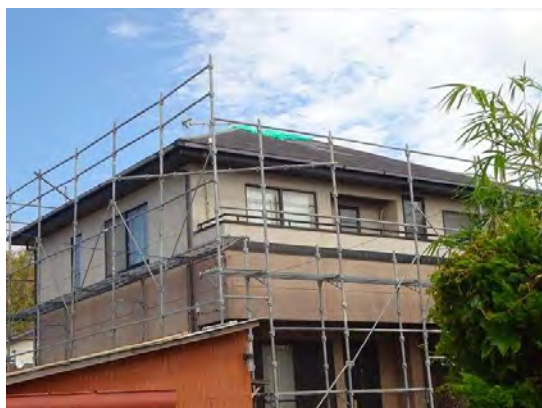
写真 17. 化粧スレート屋根の頂部に養生シート設置。
