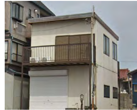
(金属屋根・折板葺き)
