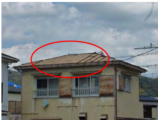
写真 46. 金属屋根（瓦棒葺き）。平部・棟部が飛散。心木ごと飛散。
