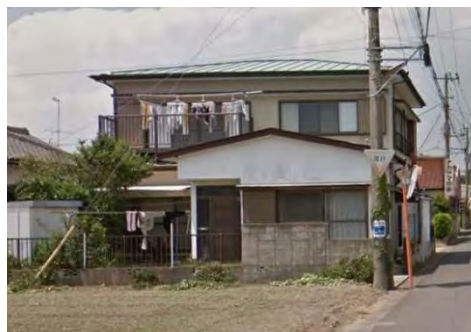
(金属屋根・瓦棒葺き)
