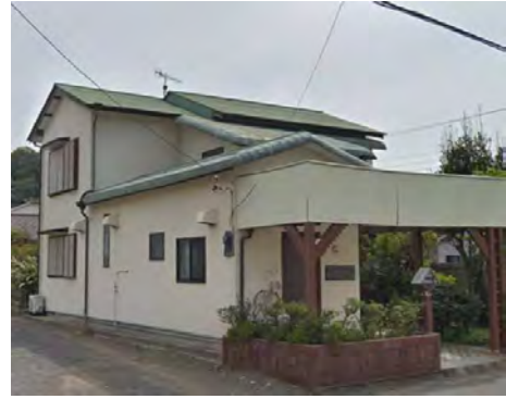
(金属屋根・銅板葺き)
