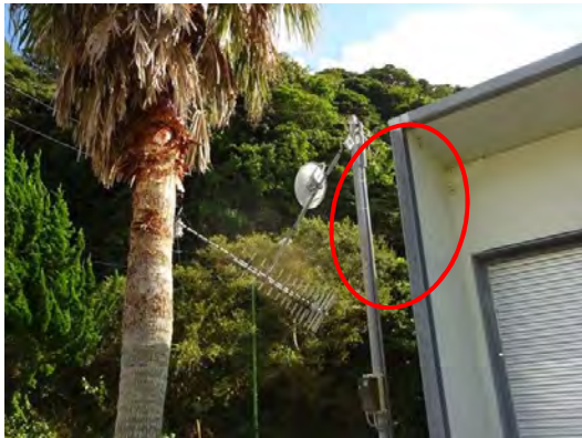
写真 57. 衛星のアンテナは折れていた。 この周辺も強風が吹いていた。
