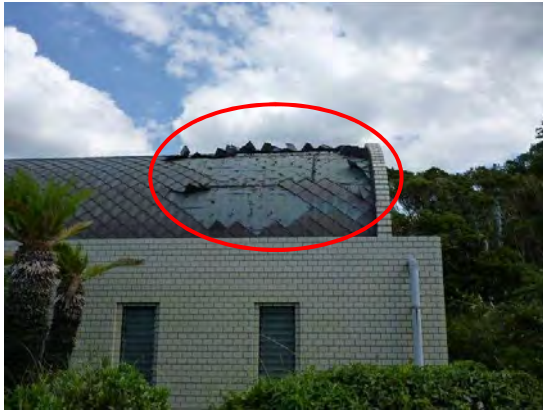
写真 42. 金属屋根（菱形形状）。平部が飛散。
