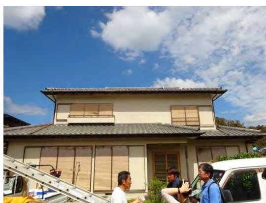
写真 15. 瓦屋根 (J 形瓦) : 平部のくぎ打ち有・飛散なし。
