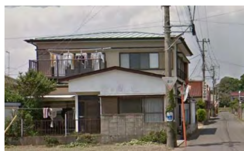
写真 20. 19 は Google map で見ると金属屋根（瓦棒葺き）の屋根でした。
